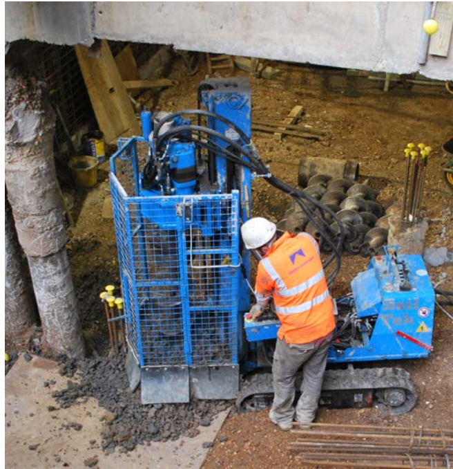
Figure 14. Restricted access mini piling rig
